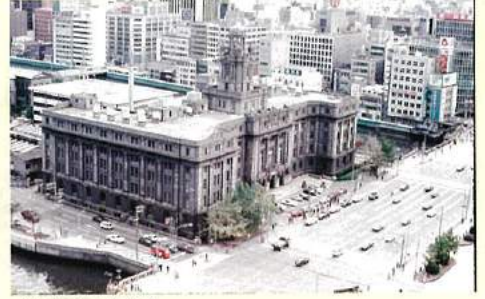
大阪市役所旧庁舎
